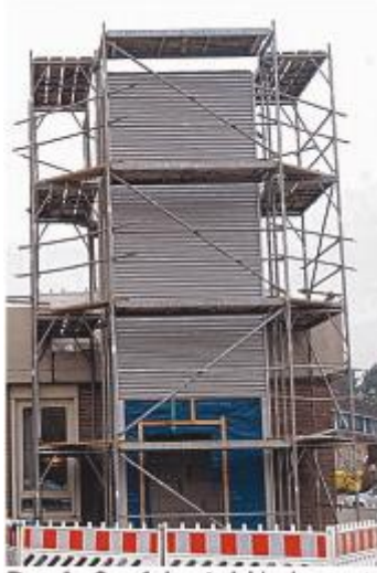
Der Außenfahrstuhl bekommt bald ein Innenleben. Foto: dew
